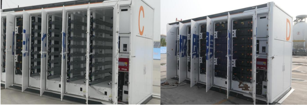
Konteyner C & D'nin yanma sonrası iç görünümü
