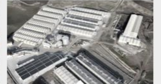
Gaziantep / 1126 kWp ISOTRAP S Eğimli Çatı Sistemi
