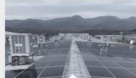
Tokat / 1300 kWp ISOTRAP XL & ISOTRAP S Eğimli Çatı Sistemi
