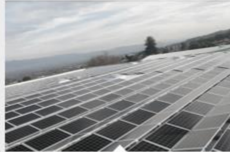
Denizli / 397 kWp ISOFLAT D13 Düz Çatı Sistemi
