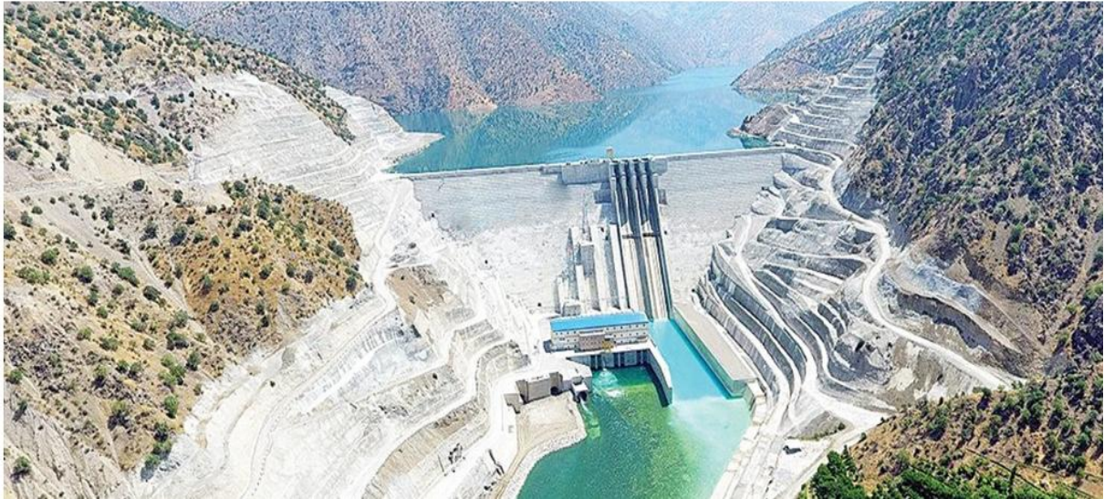
Şekil 1:Açık Çevrim pompaj depolamalı HES
